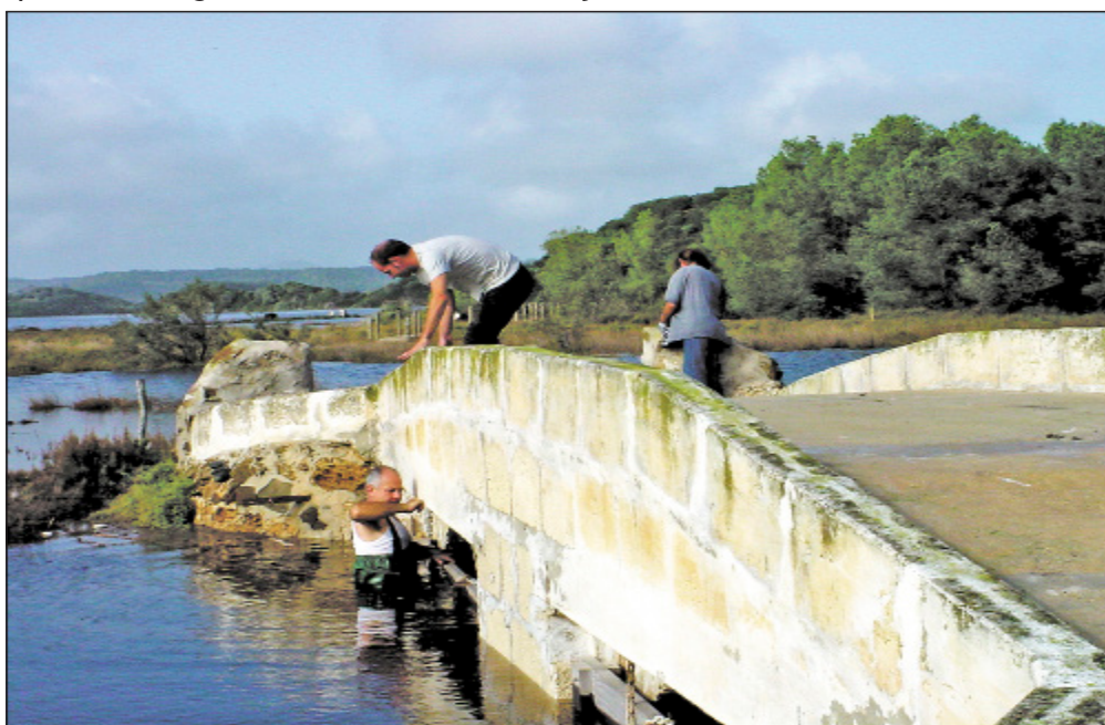
La salida de las aguas a través de la gola se controla mediante compuertas ( Artefoto )
