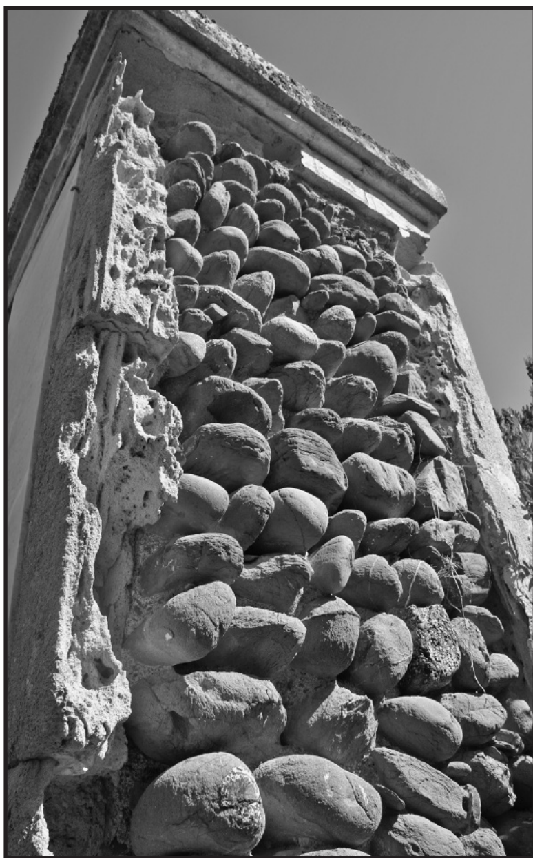
Vista de l'estat del monolit i l'originalitat de la seva construcció
