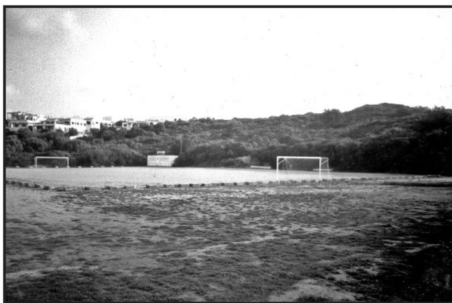
Construcció de la zona esportiva. Diferents fases
