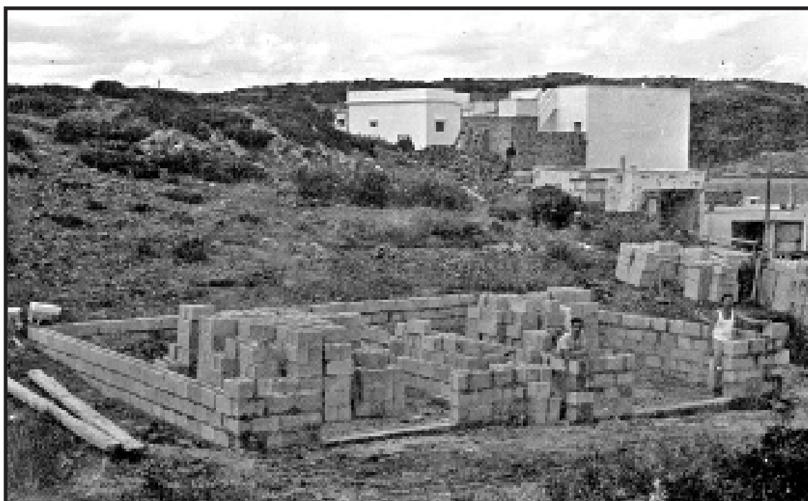
Es Grau, imatges den primer: construcció d'una nova caseta
