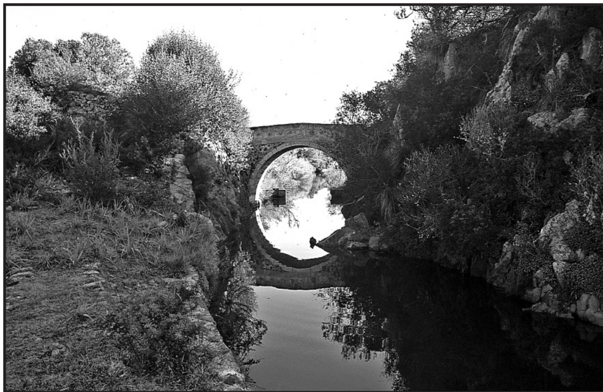
Un dels ponts que hi ha als torrents que vessen les seves aigües a la llacuna de l'Albufera
