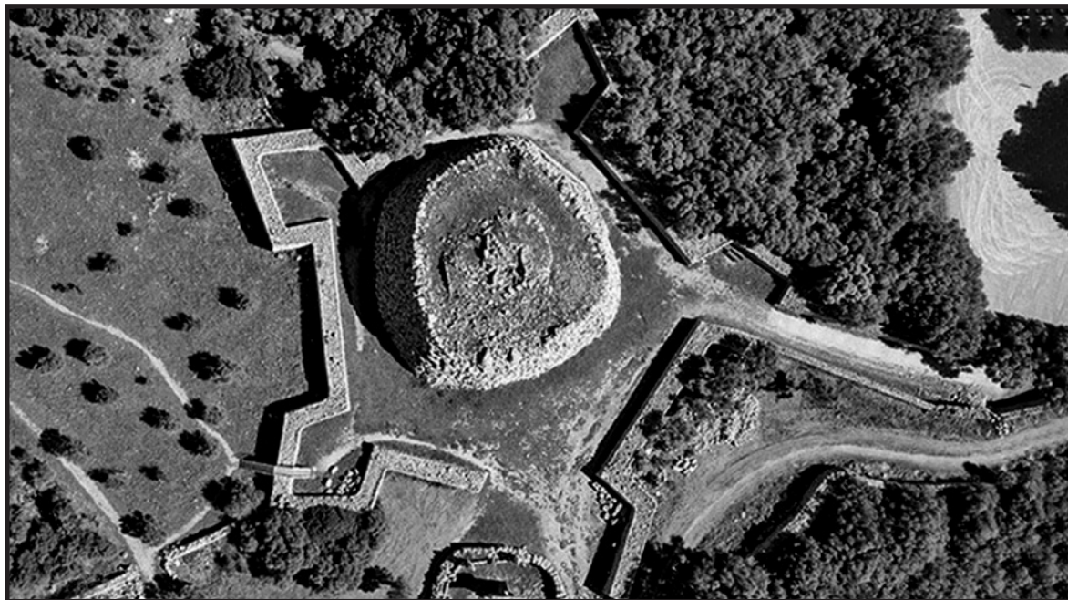
MUR DEFENSIU MANAT CONSTRUIR PEL DUC DE CRILLÓN AL VOLTANT DEL TALAIOT DE TREPUCÓ DES DEL QUAL VA DIRIGIR LES OPERACIONS DE CONQUESTA DEL FORT DE SANT FELIP
