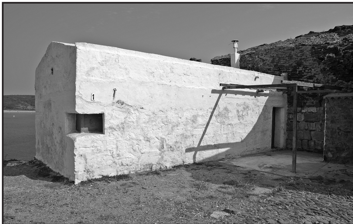
PRIMER PLA DEL BLOCAU CONSTRUÏT DURANT LA GUERRA CIVIL APROFITANT L'ASSENTAMENT DE LA BATERIA AMAGADA. DETALL DE L'ARPILLERA DE GUÀRDIA (ARTEFOTO)
